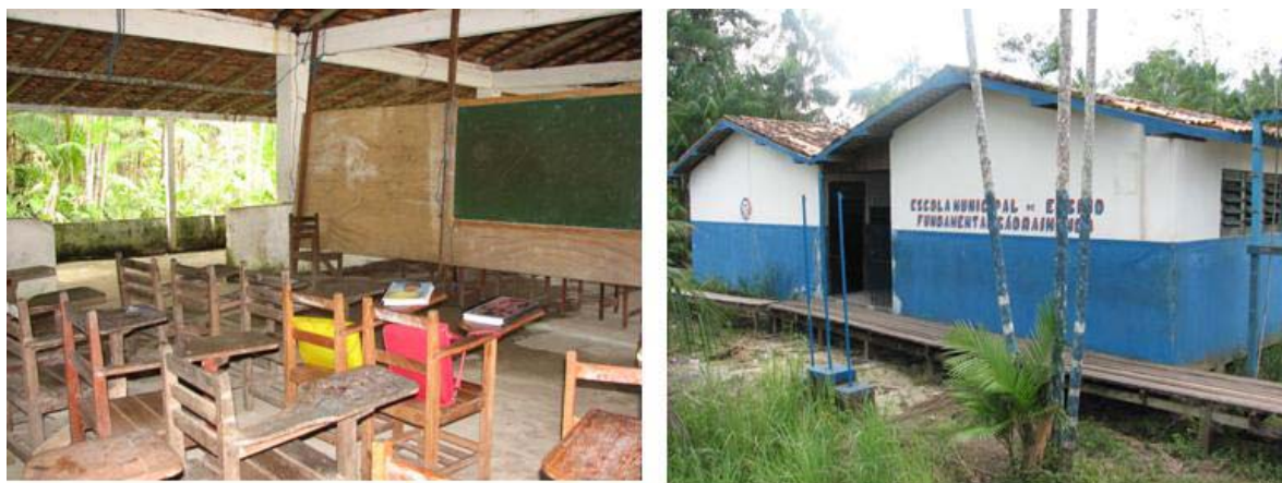
FIGURA 7: Estrutura física da escola São Raimundo no rio Sapucajuba em Abaetetuba-PA (Autora: Angélica Rodrigues).
