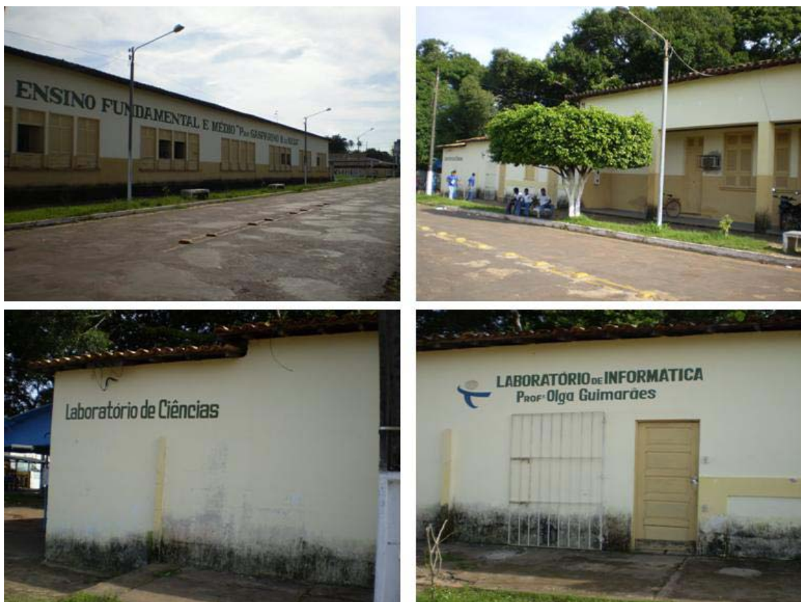
FIGURA 8: Estrutura física da Escola Gasparino em Soure, Ilha de Marajó-PA (Autora: Angélica Rodrigues).
